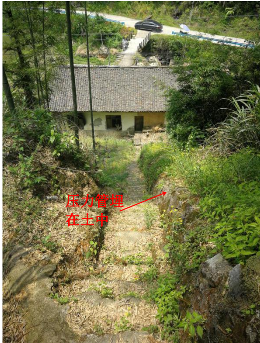
压力管线恢复情况
