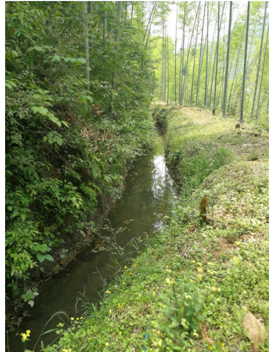
引水渠恢复情况
